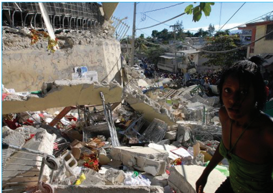
Figure 1. L'Hôpital Universitaire de l'État d'Haïti (HUEH) presque entièrement détruit après le séisme du 12 janvier 2010.
